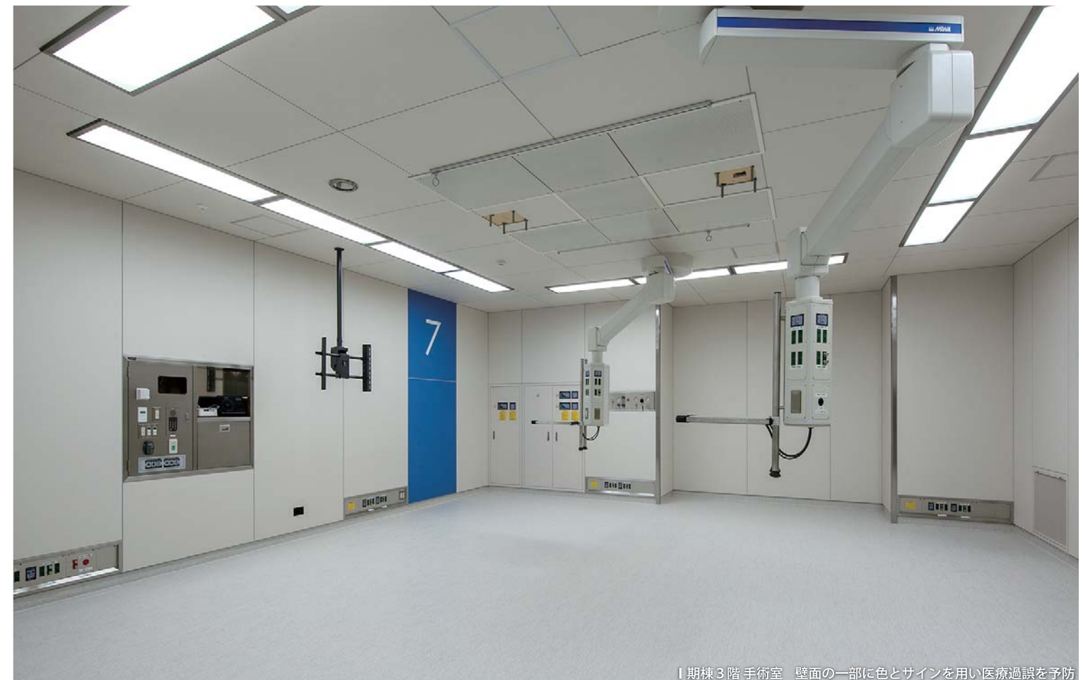
I期棟3階手術室 壁面の一部に色とサインを用い医療過誤を予防
