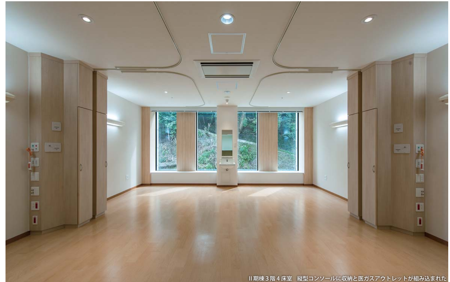
II期棟 3階 4床室 縦型コンソールに収納と医ガスアウトレットが組み込まれた
